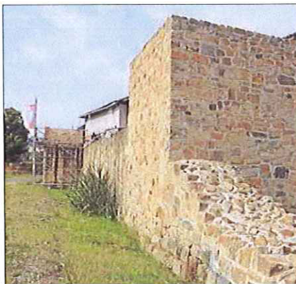
Die ehemalige Wasserburg in Petersberg-Steinau.
