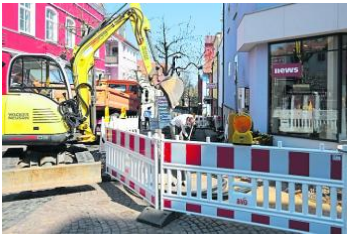
Eine der Hauptversorgungstrassen der Hünfelder Innenstadt muss durch die Stadtwerke Hünfeld erneuert werden.
