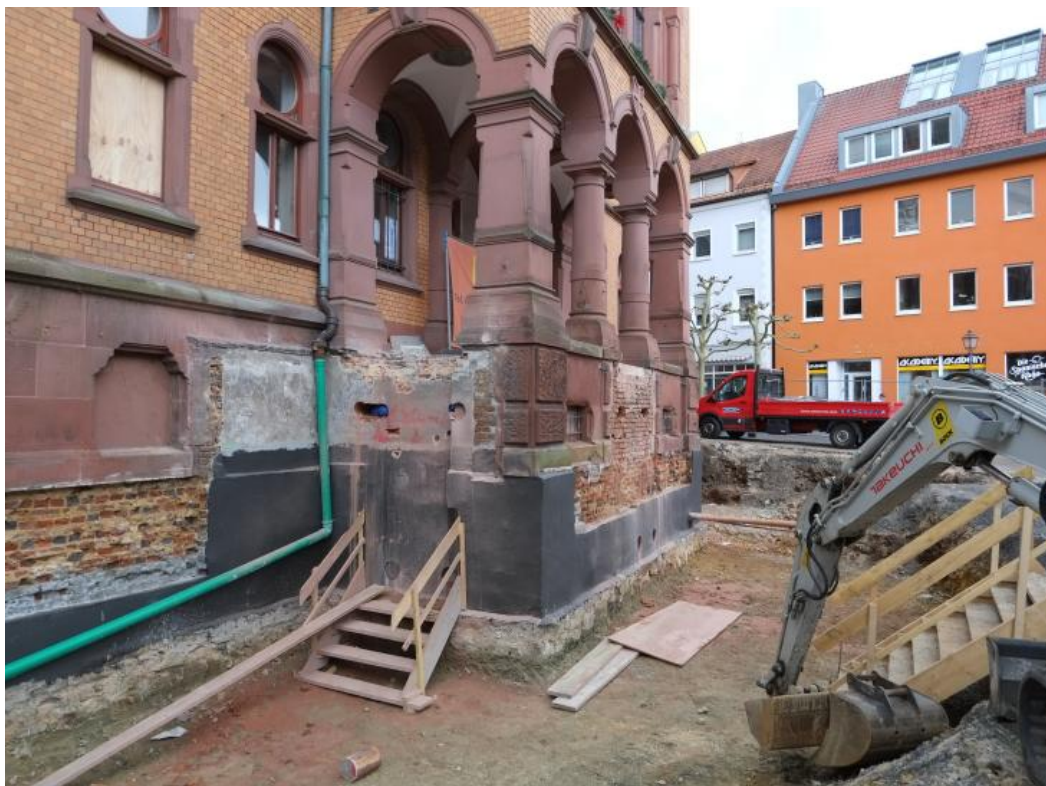
Nachdem die Treppen vor dem Rathauseingang bereits im zeitigen Frühjahr abgebaut worden waren, soll jetzt vorsichtig auch das Treppenhaus im Inneren demontiert werden, weil als brandschutztechnischen Anforderungen nicht genügt. Die neue Treppe soll auch für einen für Rollstuhlfahrer geeigneten Aufzug Platz schaffen.
