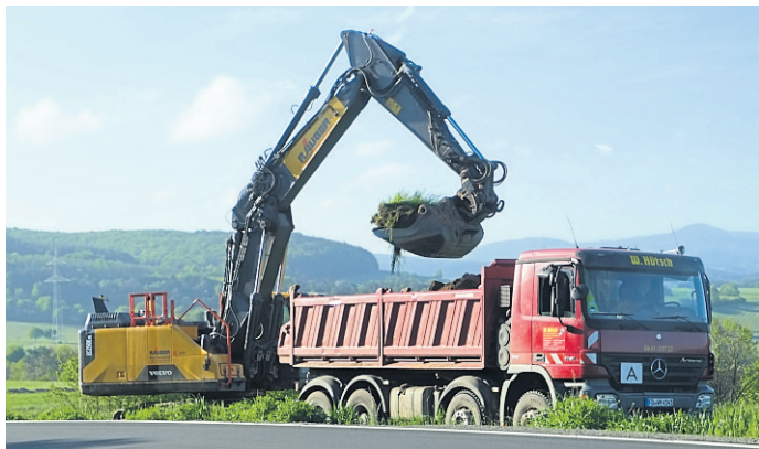
Die Bauarbeiten an der Radwegverbindung zwischen Hünfeld und Molzbach haben begonnen. Dieser Lückenschluss ist nicht nur wichtig für die Molzbacher selbst, sondern auch ein wichtiger Bestandteil des überörtlichen Radwegenetzes.
