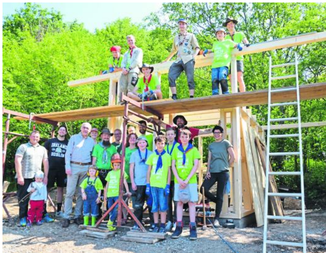
Bürgermeister Stefan Schwenk verschaffte sich vor Ort ein Bild von den Arbeiten der Pfadfinder, Eltern und Erzieher am Waldkindergarten.
