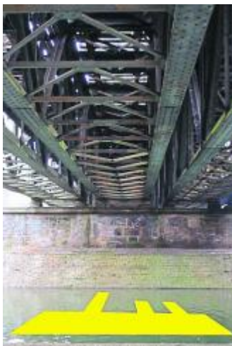
Diet Saylers „Engramm“ aus dem Jahr 2011 – eine digitale Installation unter einer Eisenbahnbrücke am Wöhrder See in Nürnberg.
