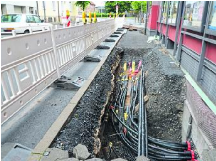
Die Bauarbeiten in der Lindenstraße gehen dem Ende zu.
