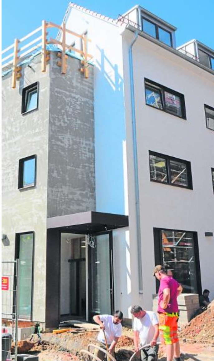
Bis auf Restarbeiten ist das künftige Bürgerbüro in der Mittelstraße 9 in Hünfeld fertiggestellt. In dieser Woche werden die Mitarbeiter bereits einziehen.
