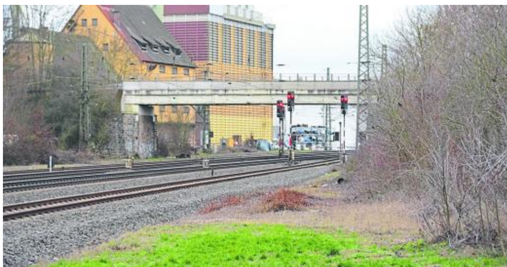
Der große „Brücken-TÜV“ steht für das Wochenende an beiden Bahnbrücken in Hünfeld und Nüst an. Dazu müssen zugpausen nachts genutzt werden.
