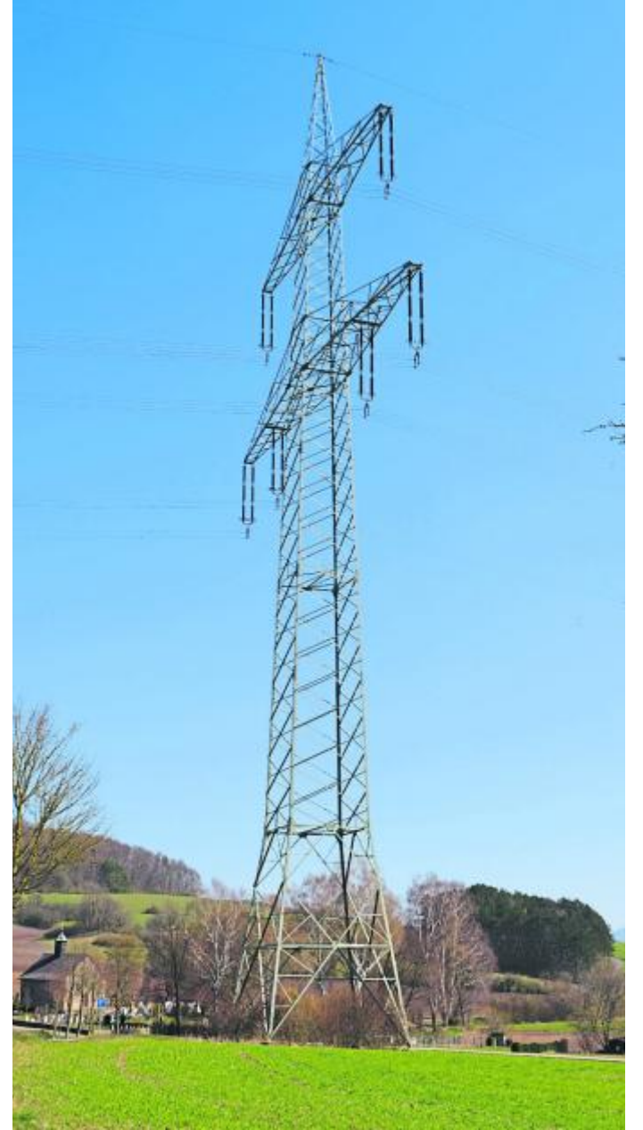
Statt rund 35 Metern Höhe könnten die Masten der Wechselstromleitung künftig bis zu 70 Metern aufragen oder durch eine zweite parallel verlaufende Trasse ergänzt werden.
