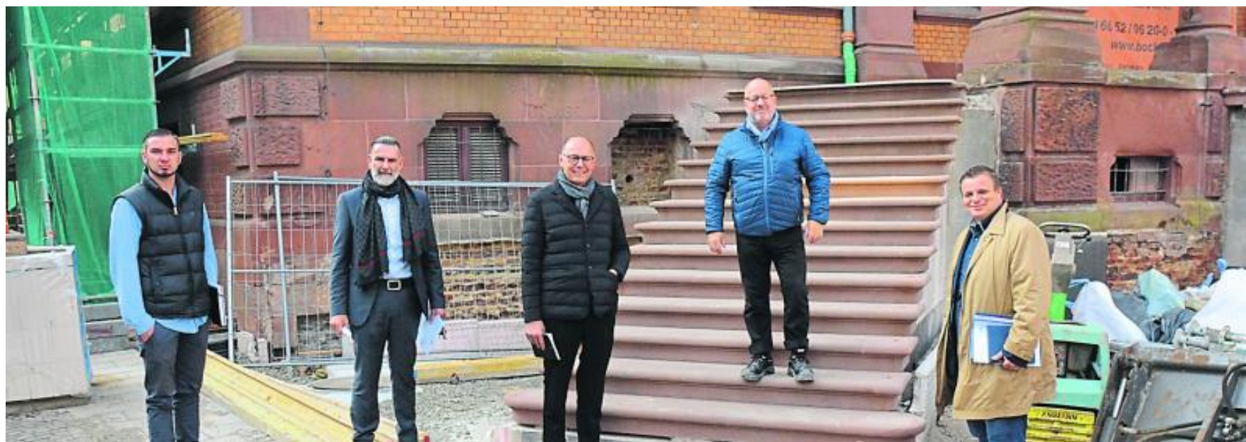
Ortstermin an der Rathausbaustelle (von links): Johann Mensch, David Schwanitz und Architekt Andreas Staubach vom Architekturbüro, Koordinator Thomas Henkel und Bürgermeister Benjamin Tschesnok im Gespräch über den Fortgang der Arbeiten.
