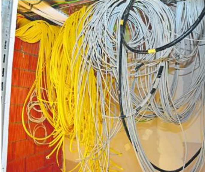
Tausende Meter Kabel werden im Hünfelder Rathaus verbaut, um das historische Gebäude auf die Anforderungen der Digitalisierung anzupassen.
