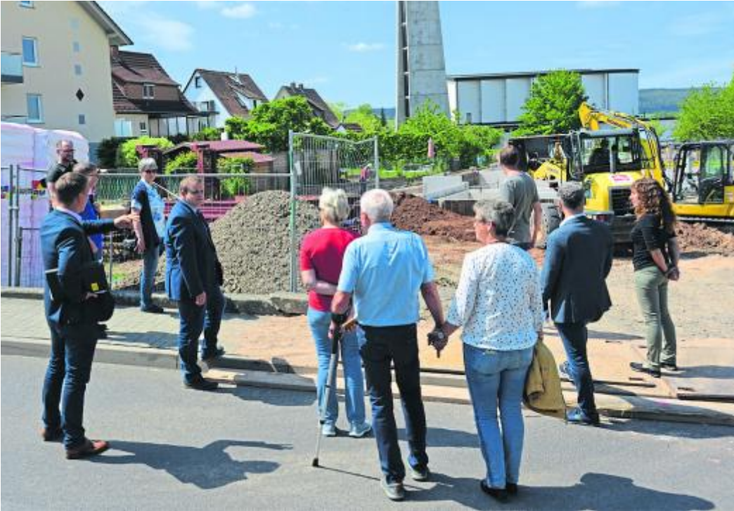
Architekt Stefan Wagner und Bürgermeister Benjamin Tschesnok informierten Mitglieder des Bürgerbeirates über den Baufortschritt an der neuen Kindertagesstätte im Hünfelder Nord- und Ostend.
