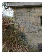
Der Wasserbehälter seitlich einen Fledermauseinflug erhalten.
