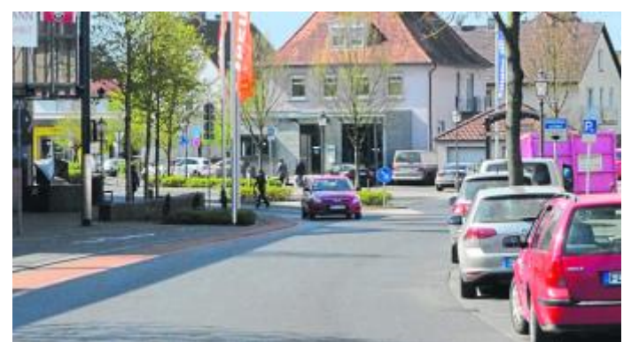
Die Josefstraße soll während der Sommerferien zwischen Neustädter Straße und Großenbacher Tor eine neue Fahrbahndecke erhalten.
