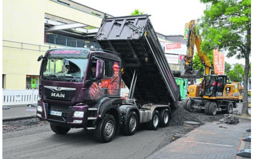
In der Josefstraße sollen die Bauarbeiten bis zum Ende der Sommerferien fertig werden.
