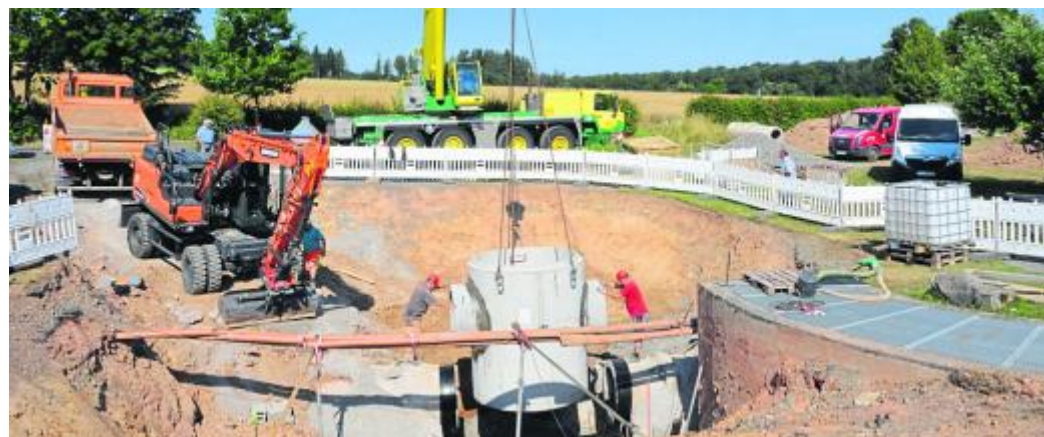
Tonnenschwer und doch Millimeterarbeit: Der neue Geschiebeschacht vor dem Regenrückhaltebecken der Dammersbacher Kanalisation wurde mit einem schweren Kran eingebaut. Dort sollen sich Geröll und Splitt sammeln, damit sie nicht in die Sammelkanäle, Becken und Pumpwerke gespült werden, wo sie große Schäden anrichten könnten.
