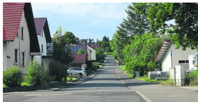
Die Straße Im Waitzfeld in Mackenzell ist in die Jahre gekommen und soll erneuert werden
