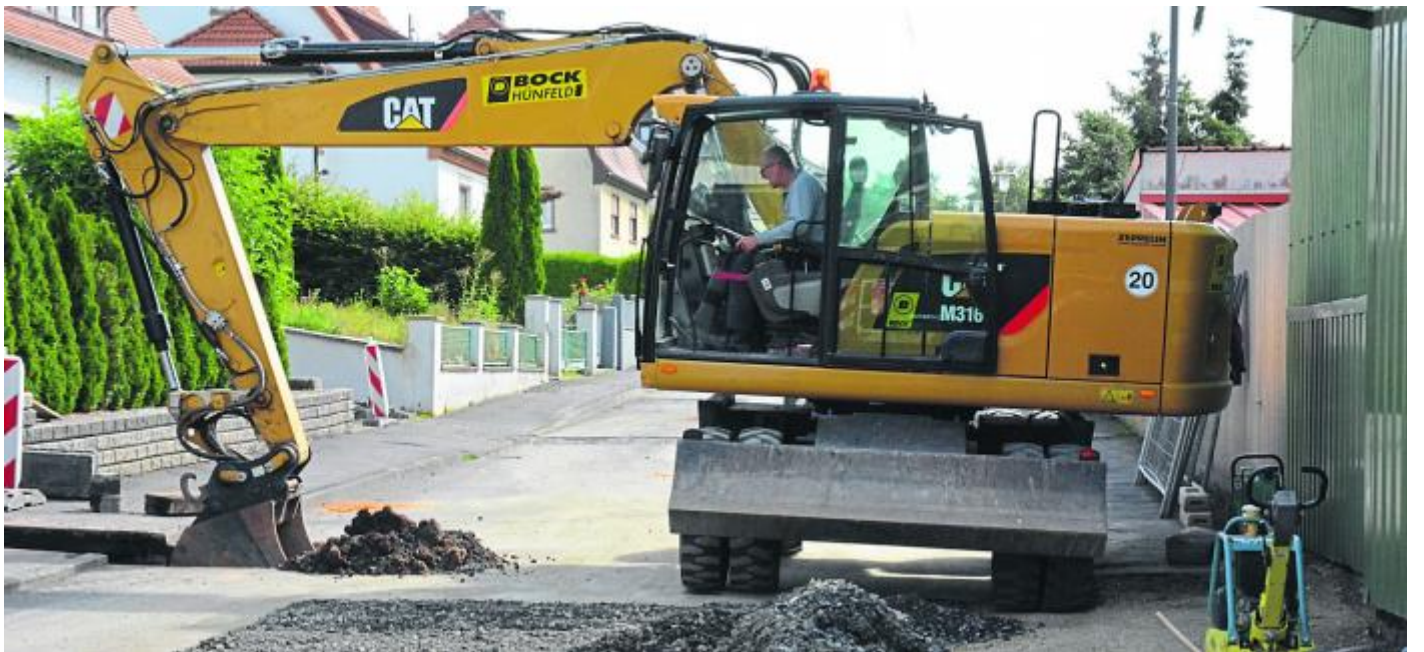
Bevor in der Berliner Straße der Ausbau beginnt, sind schon die Stadtwerke Hünfeld und der Eigenbetrieb Abwasseranlagen tätig, um dort beispielsweise Hausanschlüsse zu erneuern.
