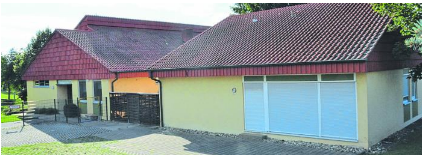
Das Bestandsgebäude des Kindergartens St. Jakobus kann nicht mehr nach den Maßstäben einer modernen Tagesstätte umgebaut werden. Deshalb soll ein Neubau entstehen.
