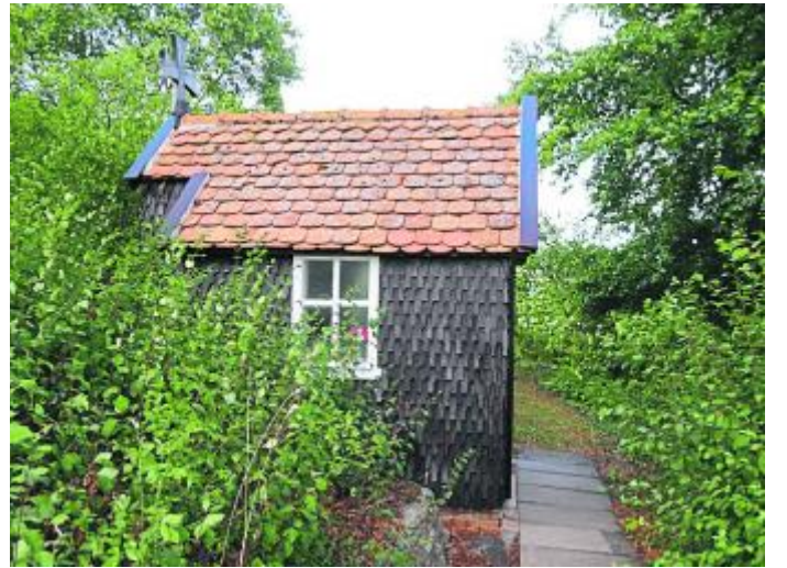
Von Grund auf renoviert wurde die kleine Gefallenekapelle am Großenbacher Friedhof durch ehrenamtlichen Einsatz der Mitglieder der Interessengemeinschaft Gefallenekapelle. Das kleine Gebäude wird in diesem Jahr 70 Jahre alt.
