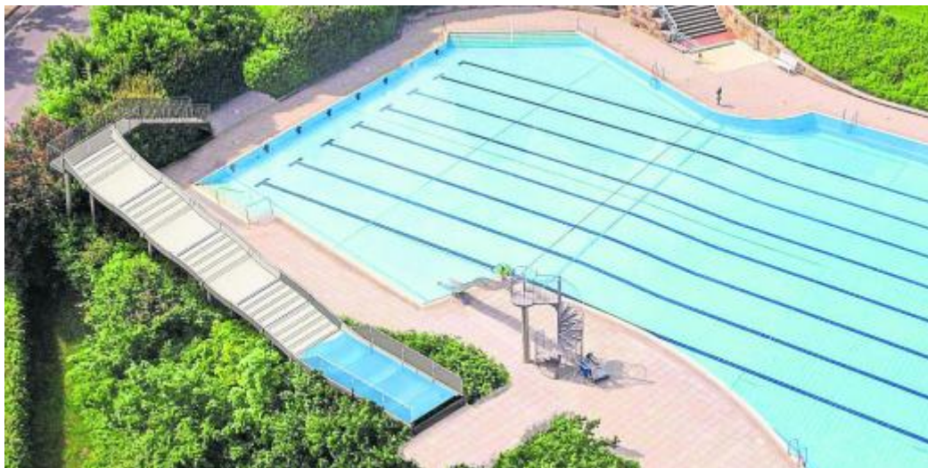
Die große Wellenrutsche für das Hünfelder Freibad wird von einem Fachunternehmen in Rasdorf gefertigt und soll anschließend auf den Fundamenten aufgebaut werden, die derzeit hergestellt werden.
