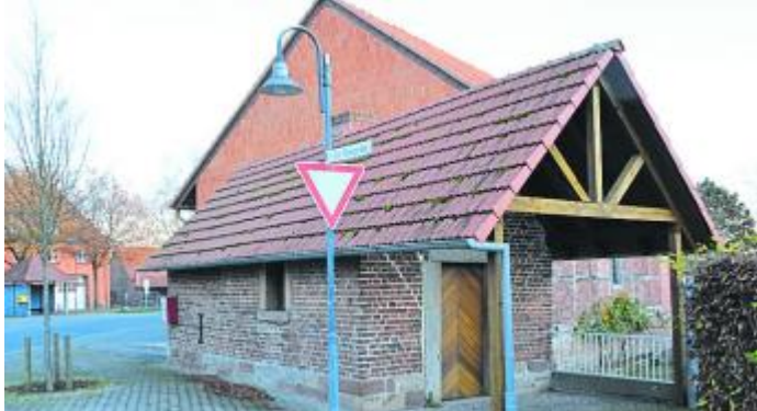
Das Backhaus in Rudolphshan soll innen und außen saniert werden. Dazu ist jetzt ein Bewilligungsbescheid aus der Dorferneuerung eingetroffen, durch den die Finanzierung sichergestellt wird.
