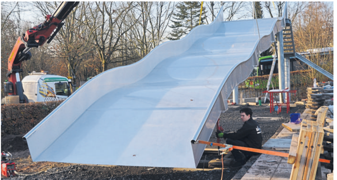
Die Breitwellenrutsche wurde diese Woche montiert.
