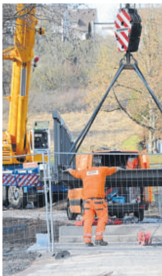
Mit einem Schwerlastkran wurde das Brückenbauwerk über die Hasel bei den Tennisplätzen in Hünfeld an seine Position gehoben.
