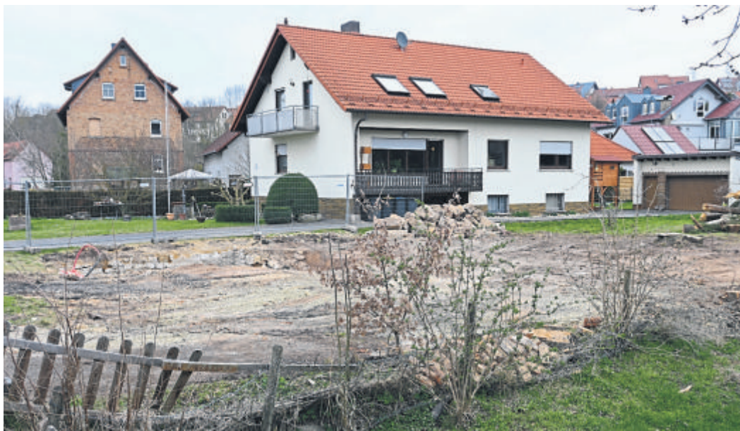
Das nicht mehr sanierungsfähige Haus gegenüber der Kirche in Nüst wurde abgerissen. Damit entstand ein neuer Bauplatz mitten im Dorf.
