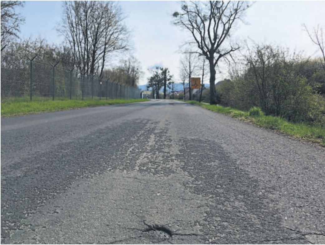
Die Molzbacher Straße wird entlang des Bundespolizeigeländes erneuert.
