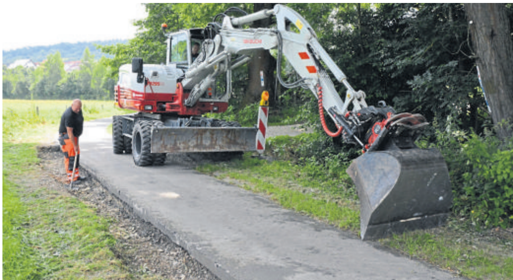
Der städtische Bauhof setzt Banketten des Radwegs in Großenbach instand, die vom Starkregen ausgespült worden waren.
