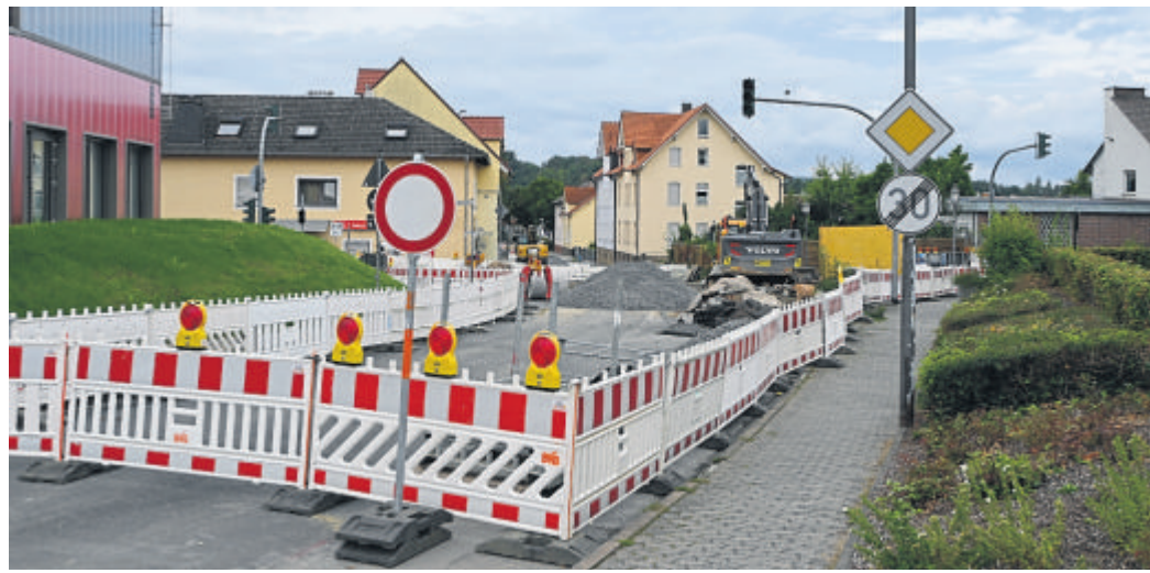
An die Baumaßnahmen für die Ver- und Entsorgungsleitungen in der Klingelstraße wird sich der Straßenbau unmittelbar anschließen. Im ersten Bauabschnitt wird der Kreuzungsbereich zu einem Kreisverkehrsplatz umgestaltet.
