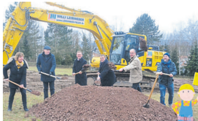
Sie gaben den Startschuss für den Bau der neuen Kindertagesstätte (von links): Stadträtin Karin Grosch, Stadtpfarrer Dr. Michael Müller, Erster Kreisbeigeordneter Frederik Schmitt, Bürgermeister Benjamin Tschesnok, Bundestagsabgeordneter Michael Brand und Architekt Stephan Wagner.
