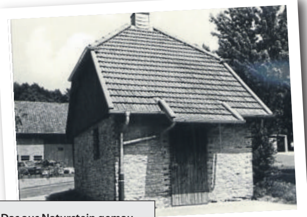
Das aus Naturstein gemauerte Backhaus unterhalb des Friedhofs wurde im Rahmen der Dorferneuerung saniert.
