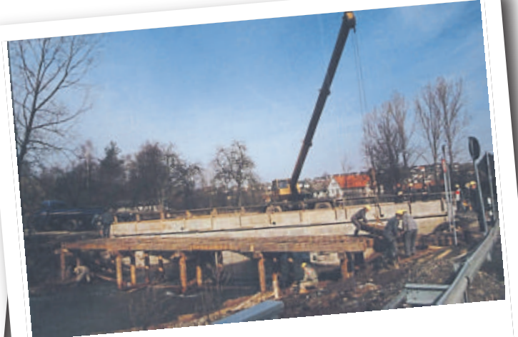
Bei der Sanierung der Barockbrücke über die Nüst errichtete das Technische Hilfswerk eine Behelfsbrücke, um den landwirtschaftlichen Verkehr während der einjährigen Bauzeit zu ermöglichen.
