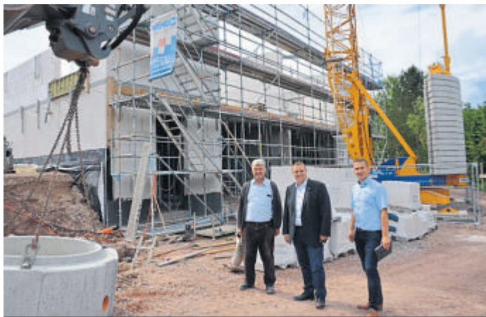
Es geht voran beim Bau der Kindertagesstätte Molzbacher Berg. Davon überzeugt sich Bürgermeister Benjamin Tschesnok (Mitte) gemeinsam mit Andreas Kapelle (rechts) im Gespräch mit Bernhard Deist.
