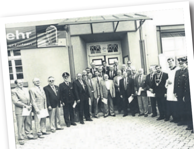
In festlichem Rahmen wurde 1989 das Kombinationsgebäude in Rudolphshan seiner Bestimmung übergeben.
