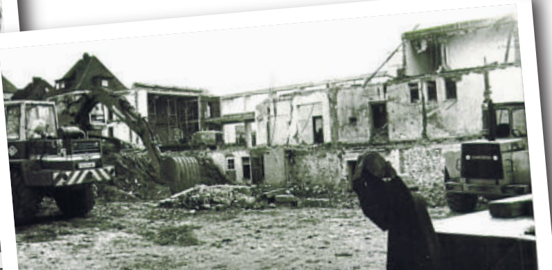
Es war tatsächlich ein Umbau, als 1968 und 87 die Stadthalle Kolpinghaus errichtet wurde.
