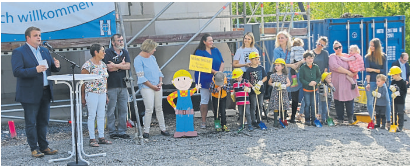
Die neue Kita am Molzbacher Berg soll im nächsten Sommer in Betrieb gehen, kündigte Bürgermeister Tschesnok beim Richtfest an. Die Kinder vom benachbarten St. Jakobus-Kindergarten haben die Baustelle aufmerksam im Blick.
