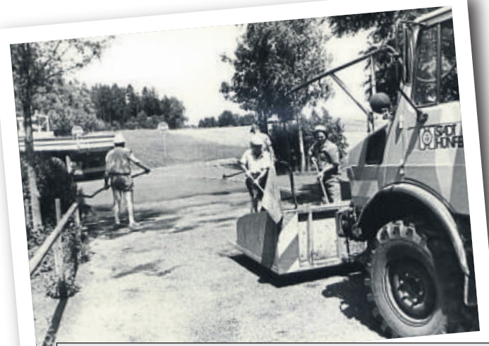
Straßensanierungsarbeiten des städtischen Bauhofs in Rückers. Mit Split und Bitumenemulsion wurde die Fahrbahn verbessert.
