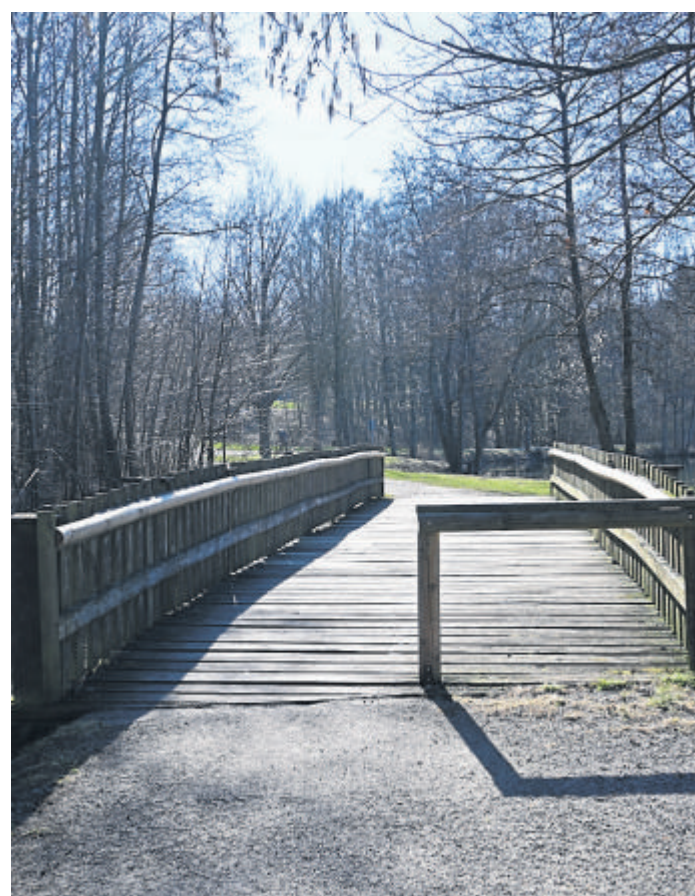
Die Holzbrücke am Haselsee ist in die Jahre gekommen und soll nach rund 35 Jahren erneuert werden.
