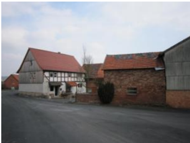
Gebäudeensemble im Bereich Am Pohl
