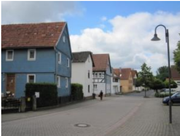
Blick in die Raiffeisenstraße (Westen)
