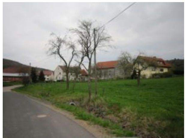
Gebäude im Randbereich des Ortskernes
