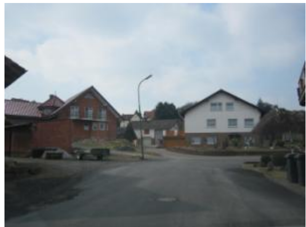
Neubauten innerhalb der Ortslage
