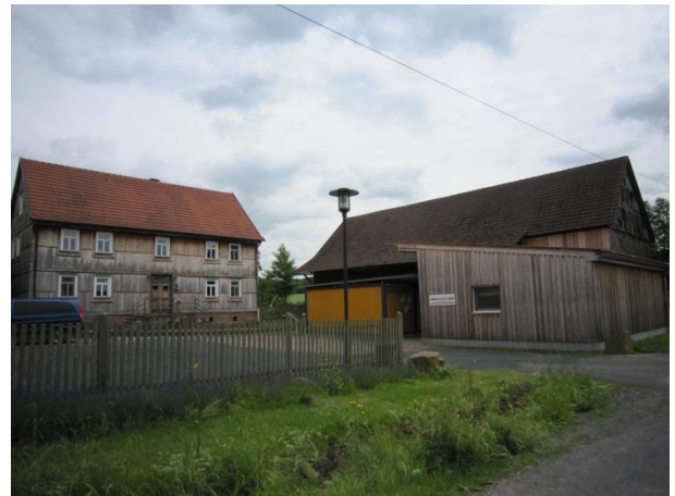
... aber sanierungsbedürftigen Bausubstanz
