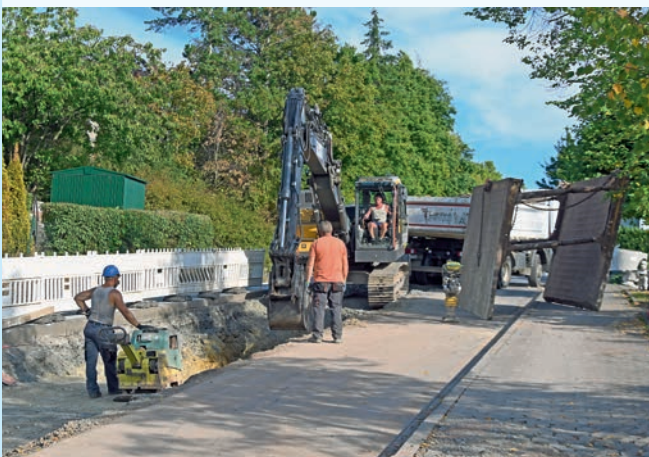
Die Molzbacher Straße wird im Sommer zur Großbaustelle. Dort finden Kanal- und Straßenbauarbeiten statt. Die Arbeiten dauern auch in 2023 an.
