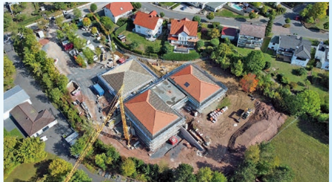
Die größte Kindertagesstätte im gesamten Kreisgebiet entsteht derzeit am Molzbacher Berg. Sie bietet vier Kindergartengruppen und zwei Krippengruppen großzügig Platz. Das Dach des dreigliedrigen Gebäudes wird auch mit Photovoltaik ausgestattet.
