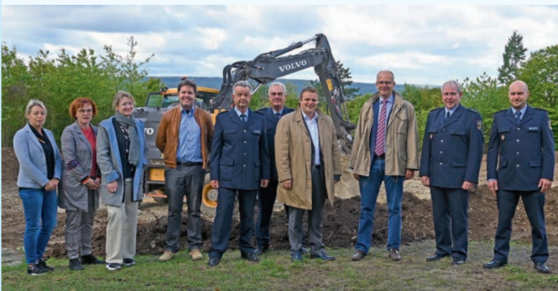
Die Bauarbeiten für die Stationierung einer zusätzlichen Einsatzhundertschaft der Bundespolizei beginnen. Bürgermeister Benjamin Tschesnok (Vierter von rechts) informiert sich vor Ort.
