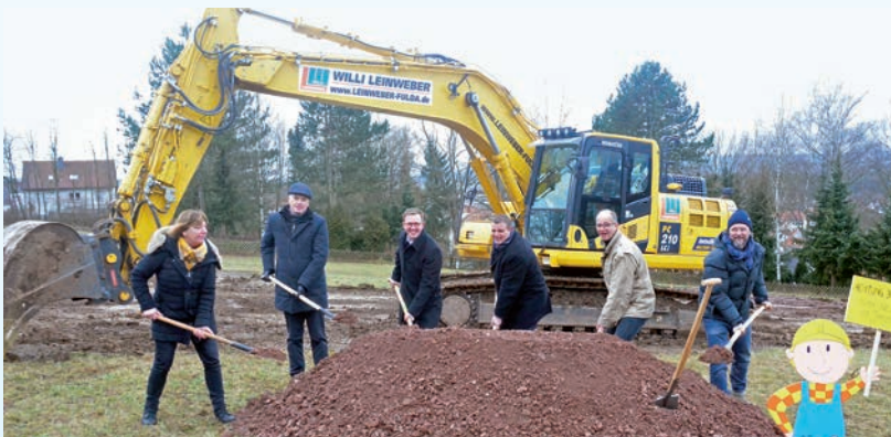
Sie geben den Startschuss für den Bau der neuen Kindertagesstätte am Molzbacher Berg (von links): Stadträtin Karin Grosch, Stadtpfarrer Dr. Michael Müller, Erster Kreisbeigeordneter Frederik Schmitt, Bürgermeister Benjamin Tschesnok, Bundestagsabgeordneter Michael Brand und Architekt Stefan Wagner.
